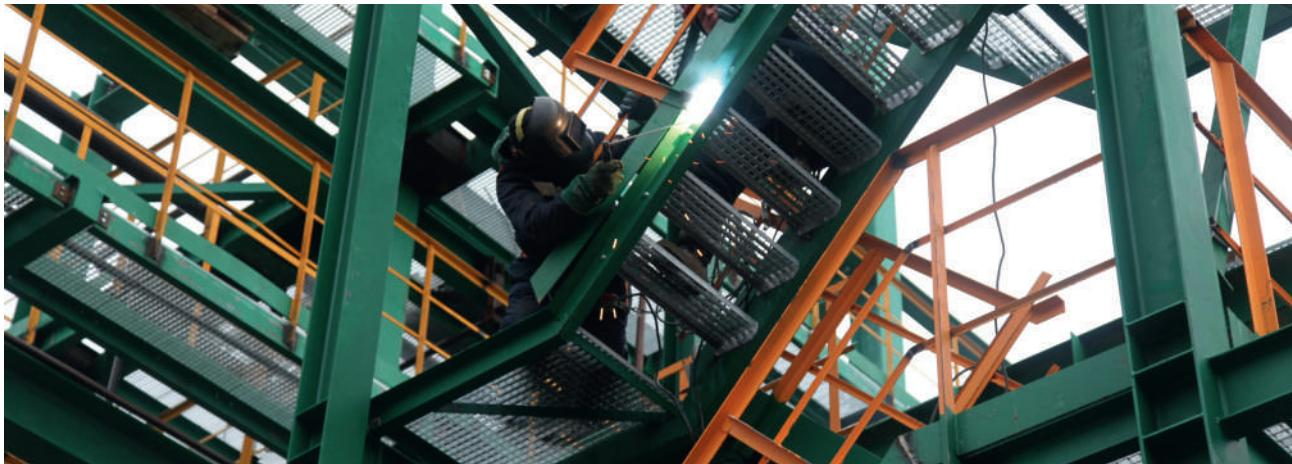
Изготовление ступеней возможно как из сварного, так и из прессованного решетчатого настила. Ступени изготавливаются как правило из стали марки Ст3, но по желанию заказчика возможно изготовление ступеней из других видов стали.
