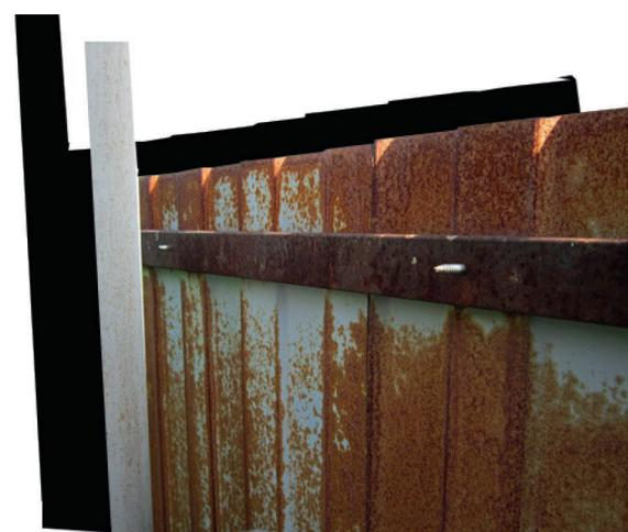
сти к дополнительным затратам в виде ремонта автомобиля или даже лечения. Дождь также не обойдет стороной «экономный» профлист, вода будет протекать в местах стыков, креплений и ржавчины, что приведет к последующей замене всего кровельного пирога на крыше и, возможно, ремонту отделки дома. Экономия в любом случае приведет к переплате.
