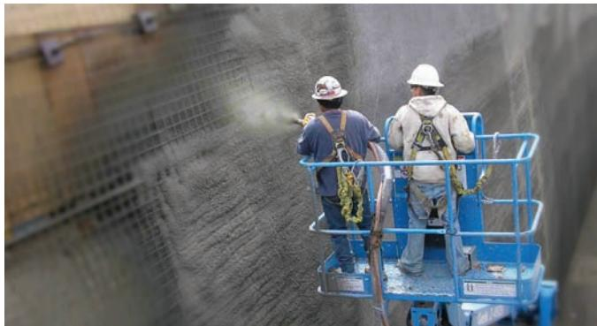
Для восстановления поверхностного слоя железобетонных конструкций, для ремонта сколов, раковин, трещин – применяют интересный способ нанесения раствора – торкремирование бетона. Суть метода – выстреливание раствором, который называется торкрем, вместе со сжатым воздухом со скоростью 120 – 180 м/с на восстанавливаемую бетонную поверхность. Торкрем обладает лучшими морозостойкими, влагонепроницаемыми характеристиками по сравнению с обычным бетоном, а также более прочен.
