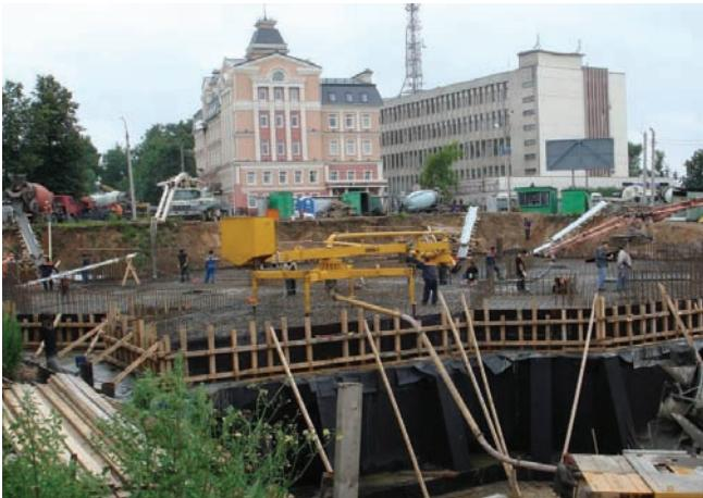
Строительство 17-ти этажного монолитного жилого дома и многоярусного паркинга. На фото – бетонирование фундамента, монолитной плиты объемом 1200м3. г. Иваново. 2009 г.
