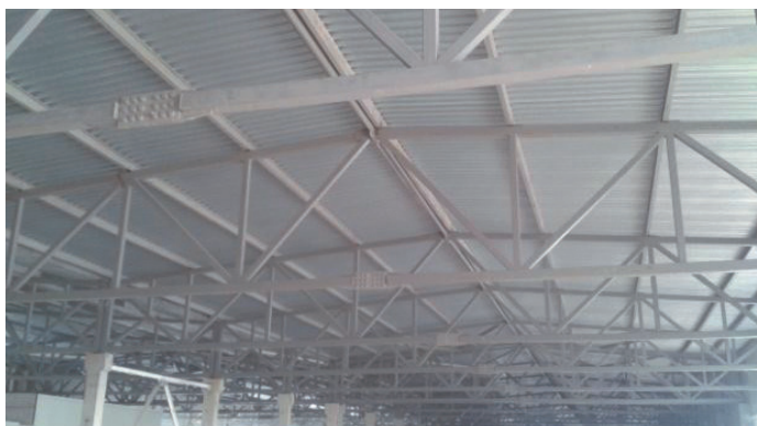
Металлические фермы по объекту «Аптечный склад», кол-во 46 тонн. Ивановская область, Ивановский район, д. Коляново, ул. Рябиновая, д. 10а.
