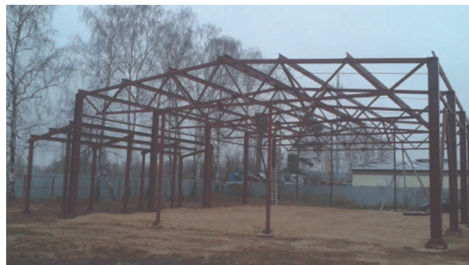
Металлоконструкции Автотехцентра по проекту «Ивановский р-н в районе д. Коляново (ул. Загородная)». кол-во 22 тонны.
