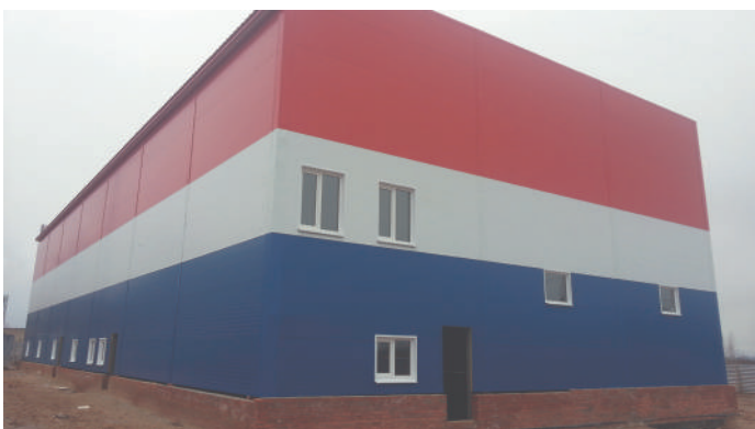
Работы по изготовлению м/к по объекту «Локальные очистные сооружения» для строительства швейной Фабрики. S=856 м2. Кол-во 80 тонн.
