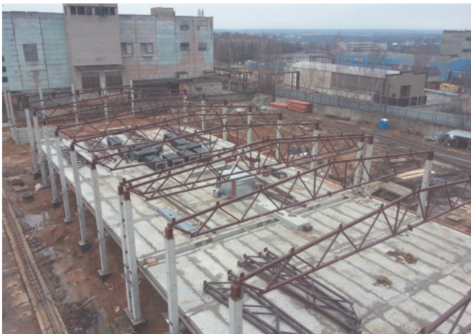
Металлоконструкции по объекту «Строительство производственных площадей для фабрики г. Фурманов». S=8184 м, кол-во 220 тонн.
