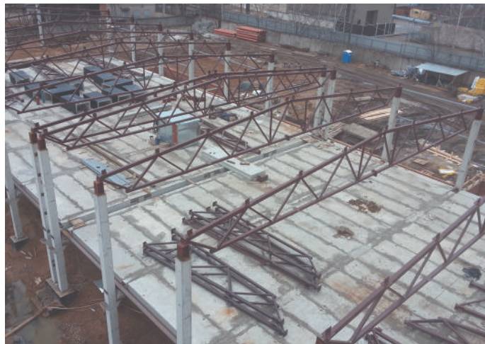
Металлоконструкции по объекту «Строительство производственных площадей для фабрики г. Фурманов». S=8184 м, кол-во 220 тонн.
