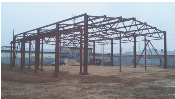
Металлоконструкции Автотехцентра по проекту «Ивановский р-н в районе д. Коляново (ул. Загородная)». кол-во 22 тонны.
