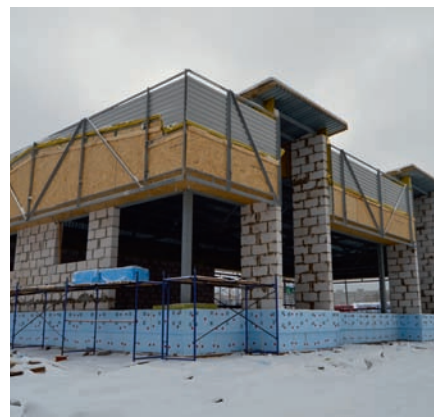
М/К для строительства кафе по адресу: г. Иваново перекресток ул. Лежневской и пр. Текстильщиков. Площадь 324 м 2 – 19,611 тн
